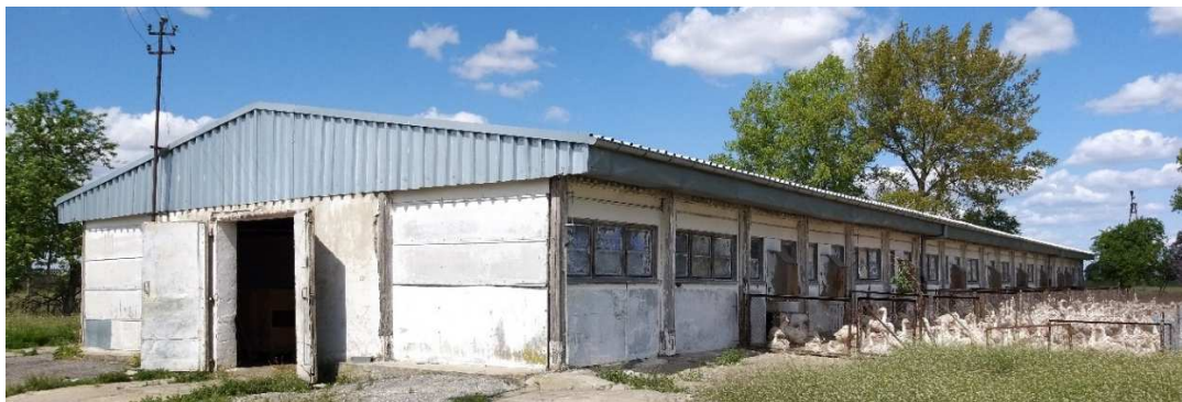
Fot.1 Widok budynku inwentarskiego do rozbiórki
