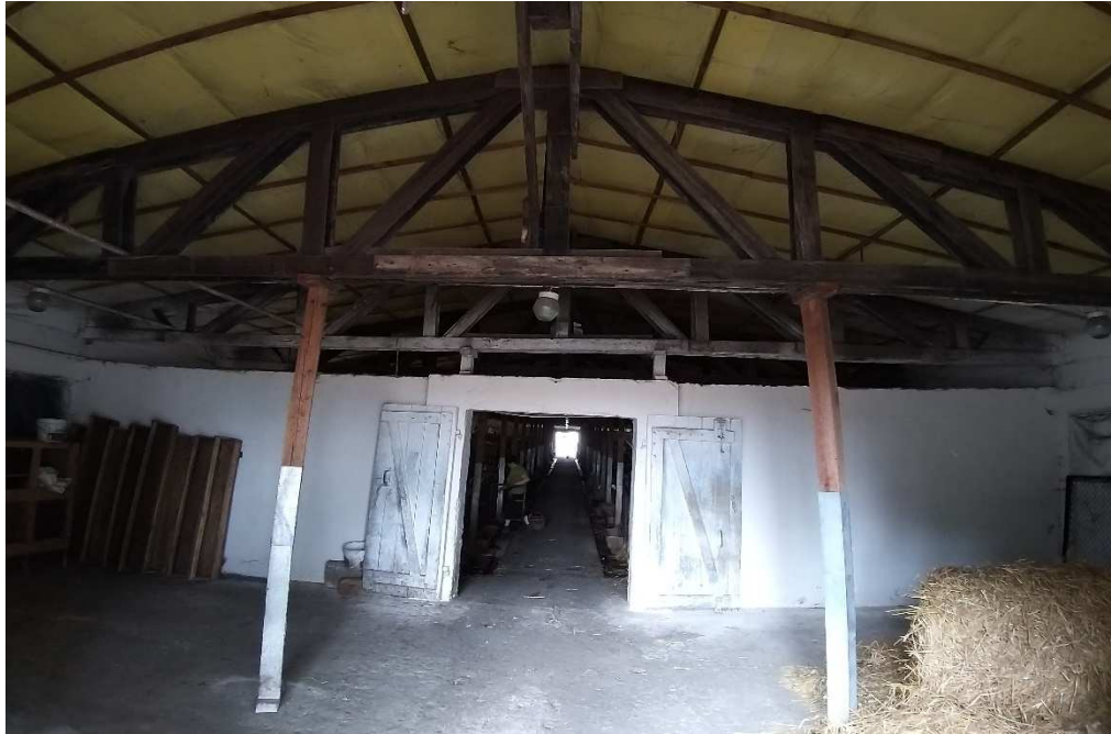
Fot.2 Widok wnętrza budynku inwentarskiego do rozbiórki
